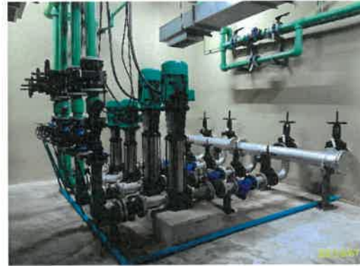
ปั๊มและถังน้ำเพื่อการอุปโภค-บริโภค ชั้นใต้ดินอาคาร A
