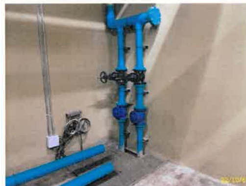
เครื่องสูบน้ำการระบายน้ำชั้นใต้ดินตัวที่ 1 อาคาร A
