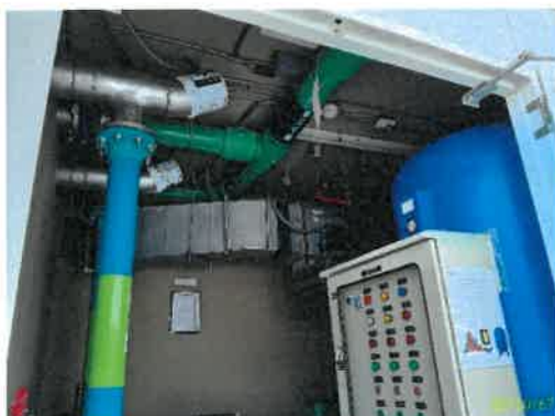
ปั๊มน้ำเพื่อการอุปโภคและบริโภคชั้นดาดฟ้า อาคาร B
