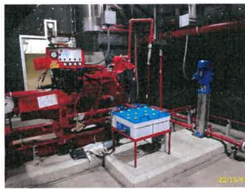
เครื่องสูบน้ำดับเพลิงชั้น 28M อาคาร A
